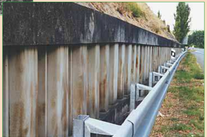
b. Soutènement d'un talus de déblai.
