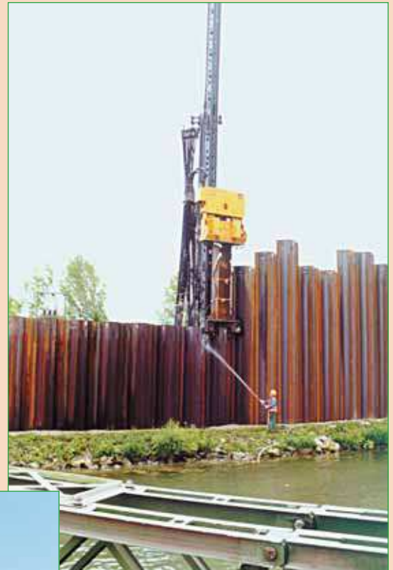
b. Fonçage par vibration.
