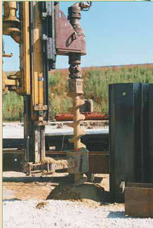
c. Préforage avant fonçage.
